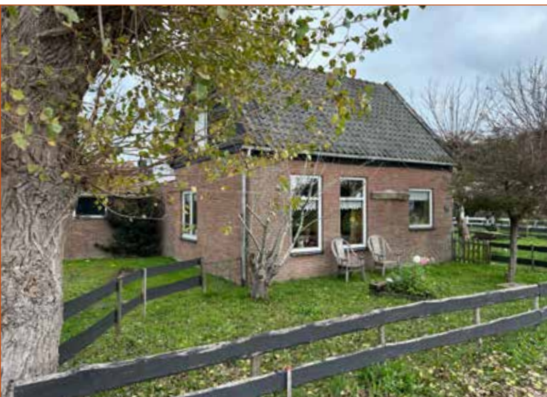
Omloop 41, westgevel, vlak voor de sloop.
