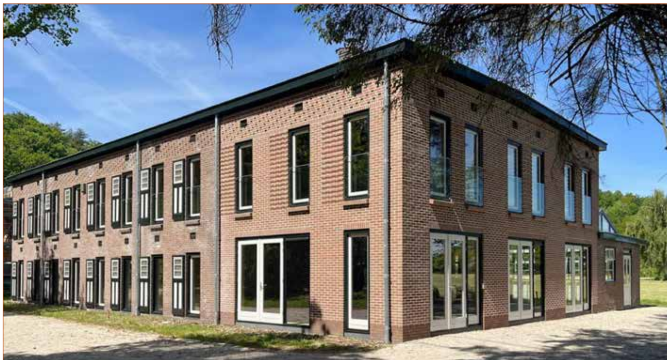
Zuidgevel en oostgevel (achter) (coll. Funda)
