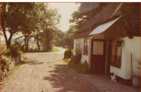
De zuidgevel van de boerderij.
