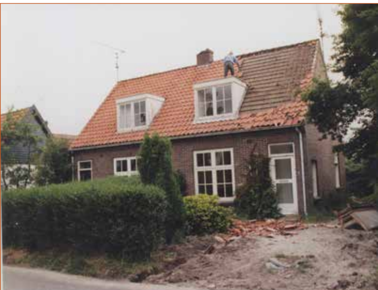
De sloop van de dubbele gemeentewoning Teugelaan 7/9 (1996) foto's Rob Henneman
