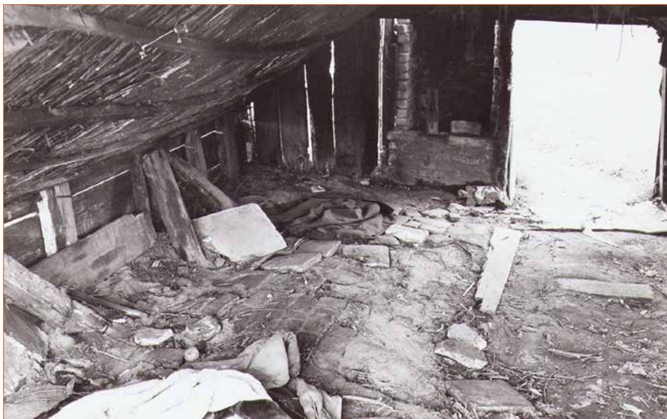
Links naast de deur de stookplaats, stro op de dakspanten en een vloer van tegels en stenen.
