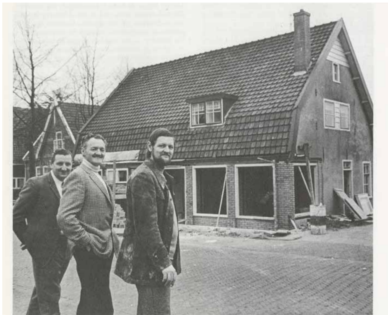
De slopershamer heeft z'n werk gedaan. Nieuwbouw legde de romantiek horizontaal; Piet, Siem en Jan Bakker
