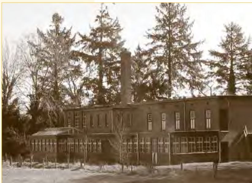
bollenschuur van Kieft, Duinweg 19
