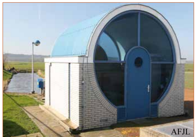
het nieuwe gemaal
