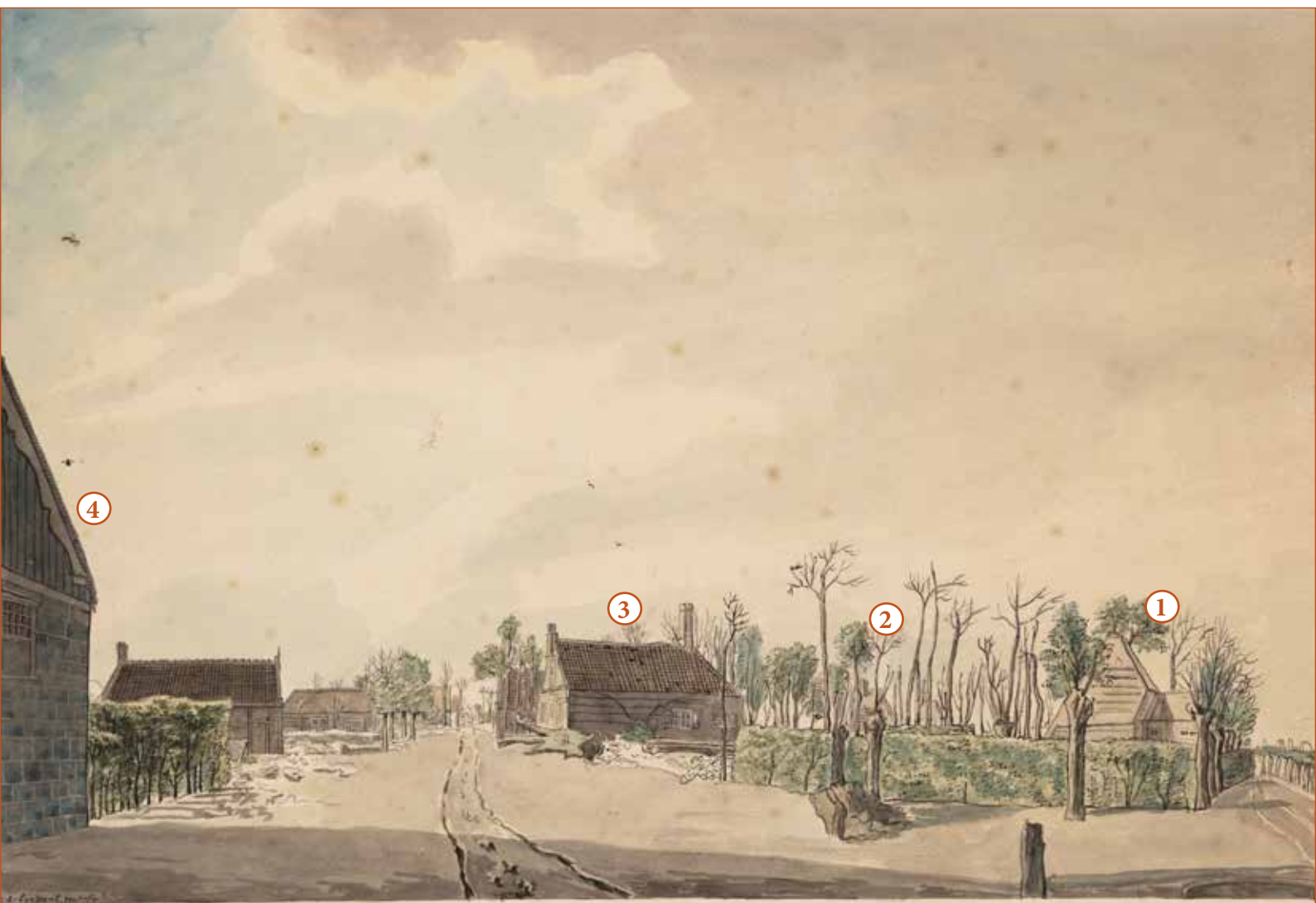
centrum Schoorl na de verwoesting tijdens de invasie van Engelsen en Russen in 1799, rechts de Laan (Laanweg) met de eerder genoemde boerderij 'Het Ooyevaarsnest' (1). de moestuin (2) was gelegen tussen 'Het Ooyevaarsnest en Heereweg 6 (gespaard) (3), waar toen nog de kroeg 'De Romein' was, later de smederij van Tinus Hoebe, geheel links een stukje van de latere 'Roode Leeuw' (4) (collectie Regionaal Archief Alkmaar)
