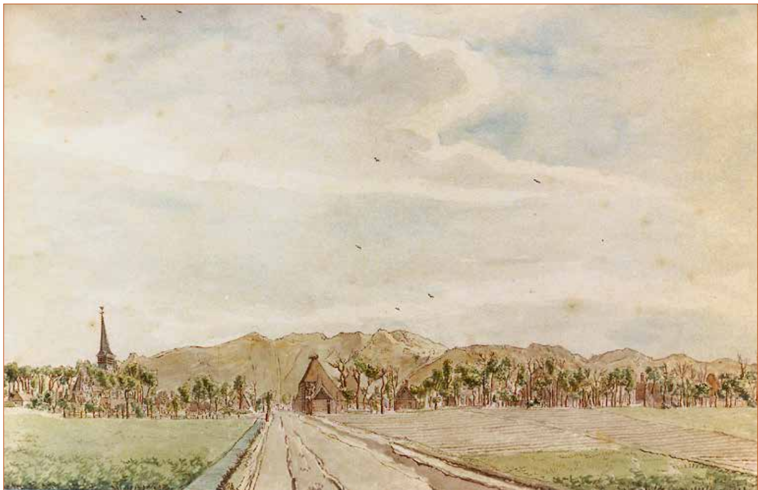
gezicht vanaf de Laan op het dorp Schoorl. Duidelijk staat benoorden de Laan de boerderij 'Het Ooievaarsnest' met inderdaad op de top van de kap een ooievaarsnest, J.A. Crescent 1799 (collectie Regionaal Archief Alkmaar)
