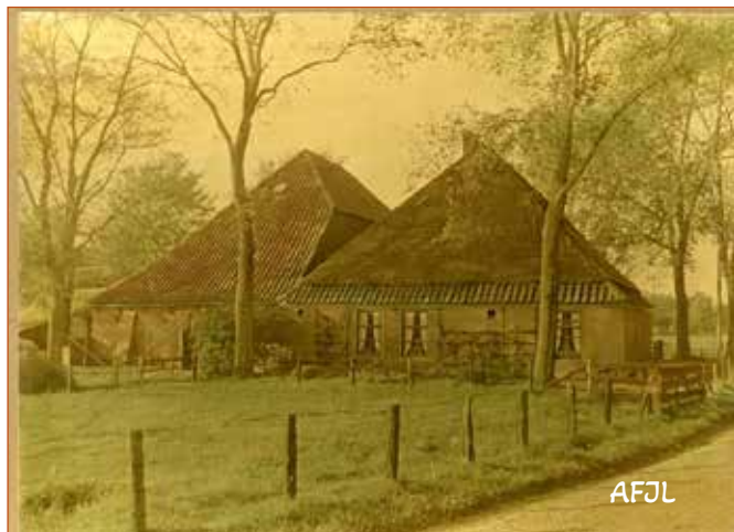
Duinweg 54, na de verbrandde voorganger herbouwd in 1894
