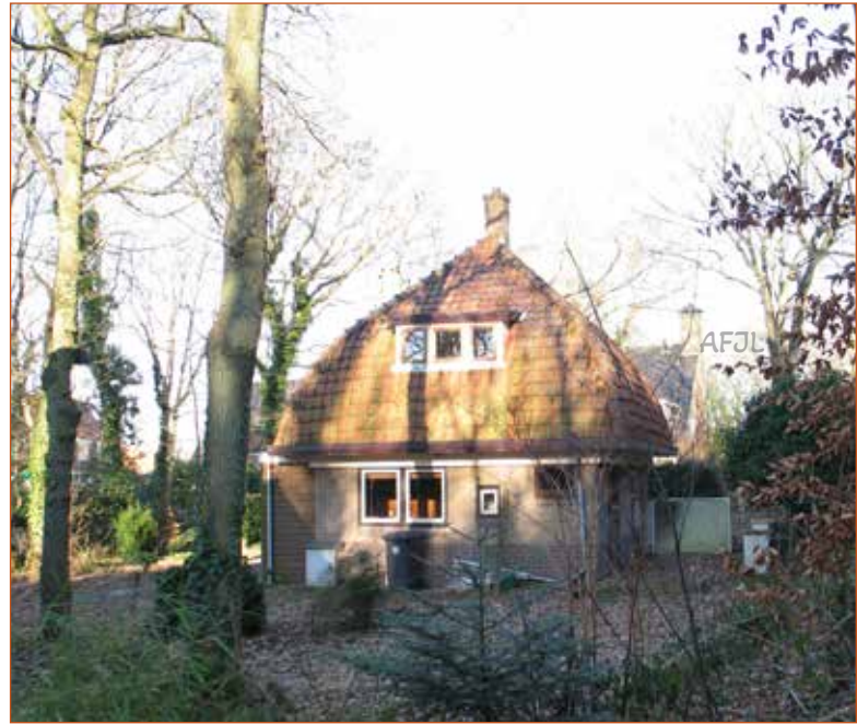
Hogenolweg 1, westelijke gevel
